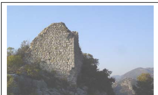
Un angle de courtine du Château des Voleurs, sur le mont Revel (appareil médiéval classique) (Photo Nicole Girard)
